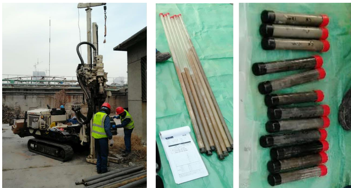
图 3.3-6 Geoprobe 系统平台专业钻探设备和现场采集到的土壤样品
